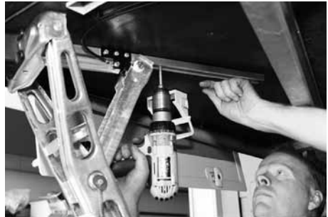
Het voorbereiden van de laatste twee bevestigingsschroeven.
