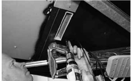
De leidingen vastschroeven aan de bodem met het meegeleverde materiaal.
