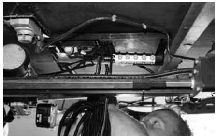
Monteren van de pomp unit
